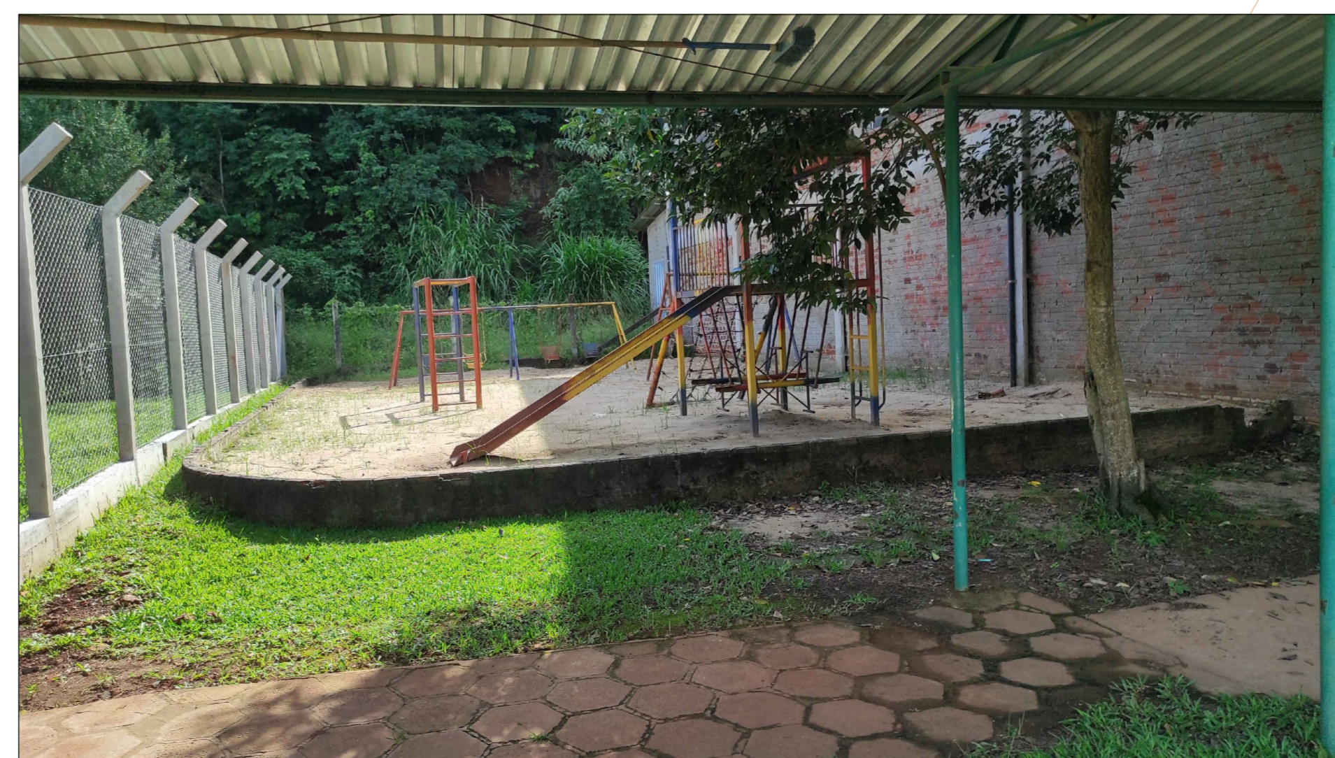
AREA DE INTERVENÇÃO - CONSTRUÇÃO DO PARQUINHO
