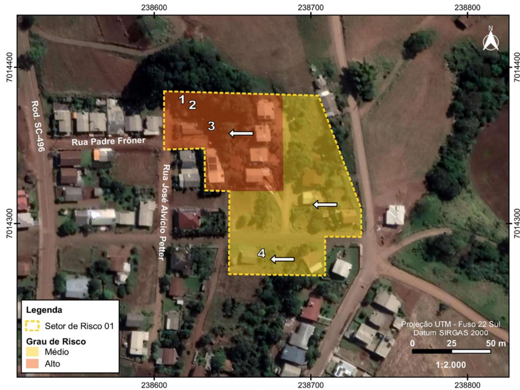
Figura 88 - Classificação de Risco do Setor 01 e fotografias da área: 1) Vista geral da encosta, mostrando a proximidade da moradia à base do talude; 2) Talude verticalizado com pequenas cicatrizes de deslizamento com moradia situada próximo de sua base; 3 e 4) Moradias próximas da base de taludes e encosta onde observam-se árvores com risco de queda.
