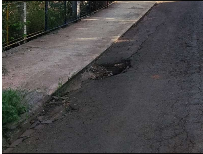
Figura 39 – Exemplo de obstrução de boca de lobo.
