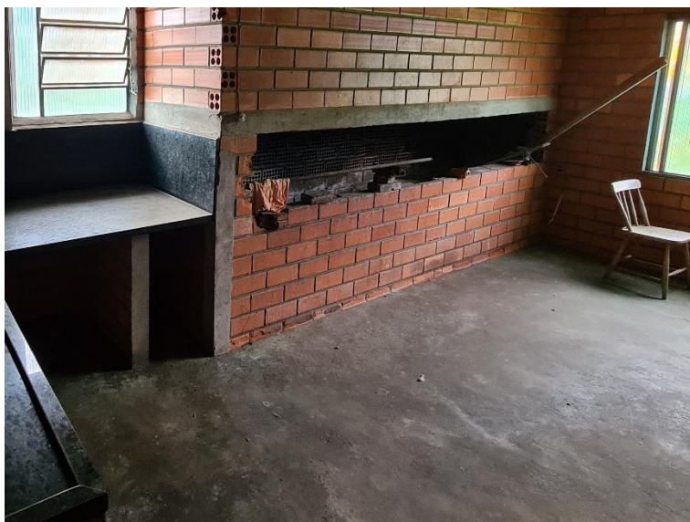
Figura 01 – Vão da churrasqueira a ser fechado com alvenaria
