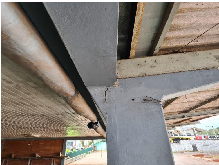
Figura 05 – Local de confecção de reforço estrutural
