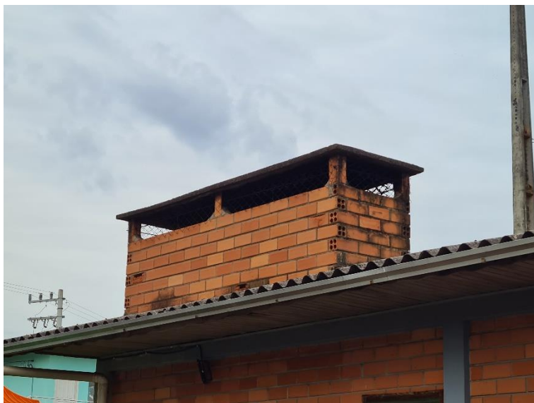
Figura 02 – Chaminé a ter sua altura ampliada em 80cm.
