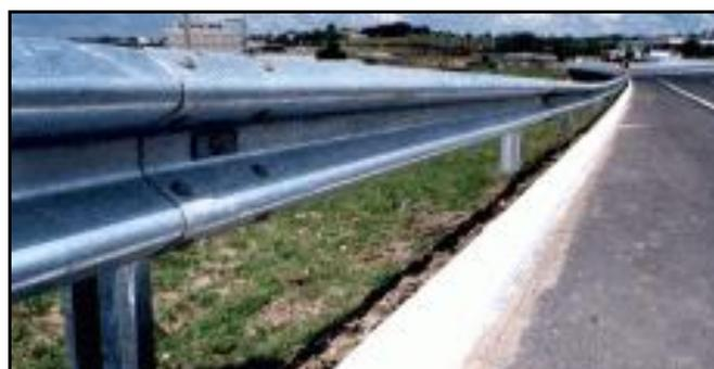
Figura 12.4 - Defesa Metálica.
