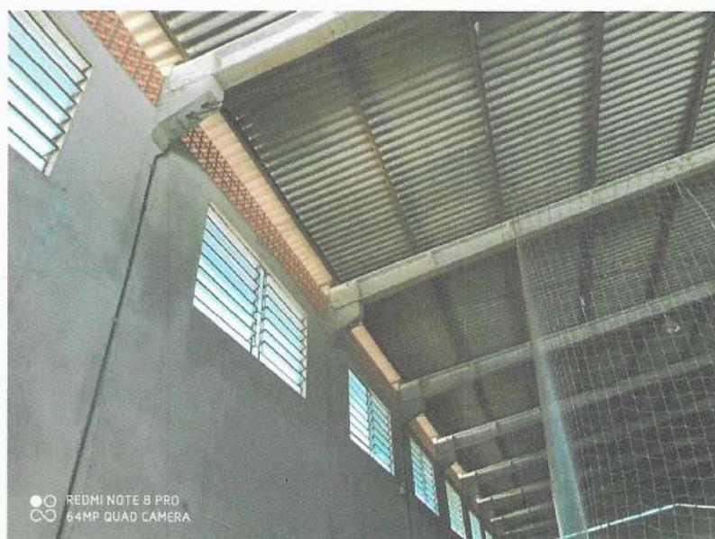
Figura 02: Sistema de engastamento da estrutura do telhado.
