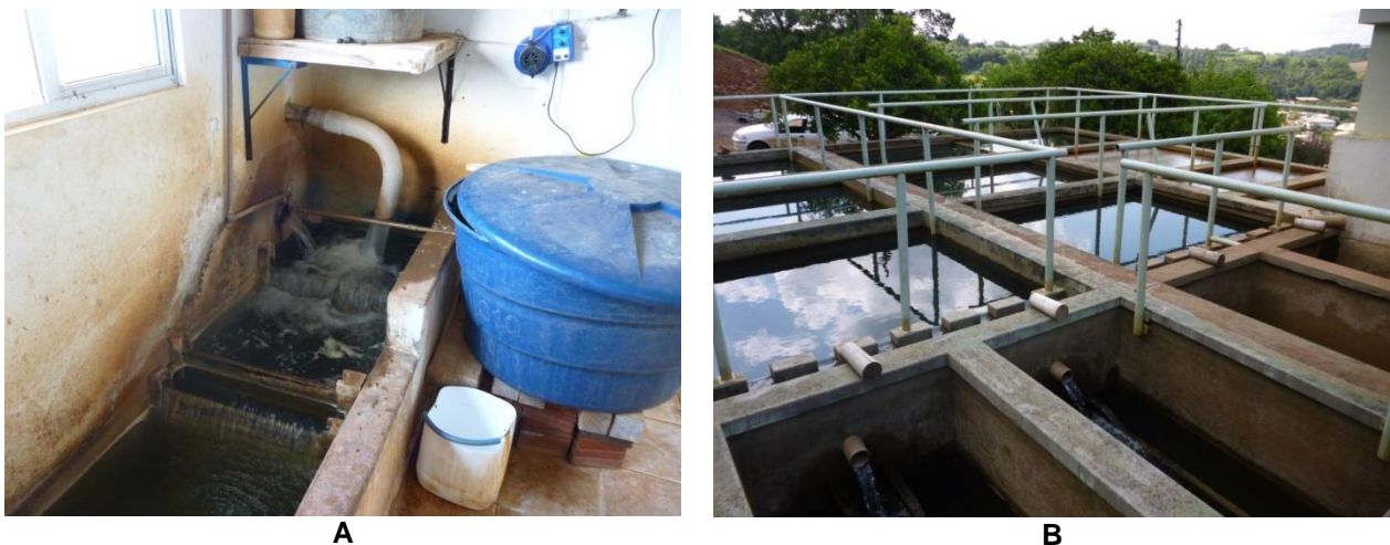
Figura 23. (A) Calha de entrada da água bruta (B) Visão geral dos tanques de coagulação, floculação e decantação.
