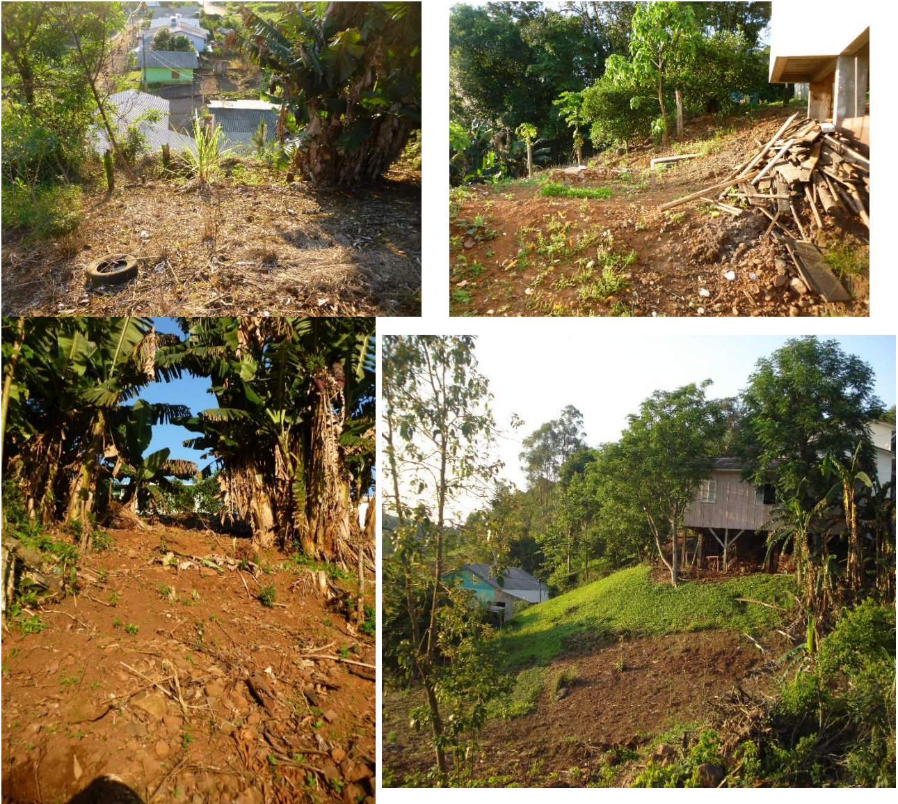
Figura 56. Edificação e usos do solo na parte superior da vertente da área de risco.
