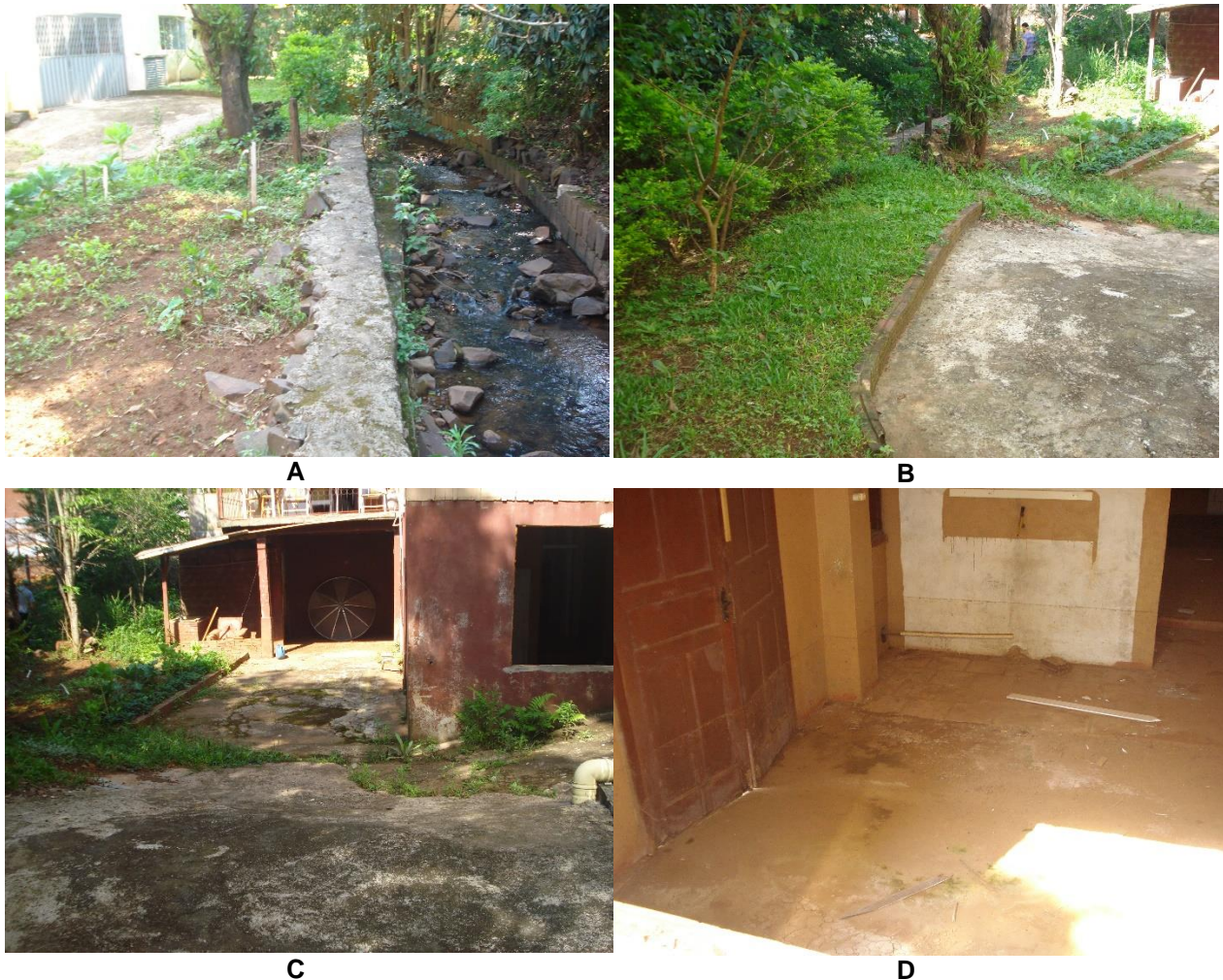
Figura 36. (A) Visão da calha encanada no Rio (B) Perspectiva da proximidade da edificação e o manancial superficial. (C) Residência impactada por eventos de inundação (D) Nível que a água chega no primeiro pavimento da residência.
