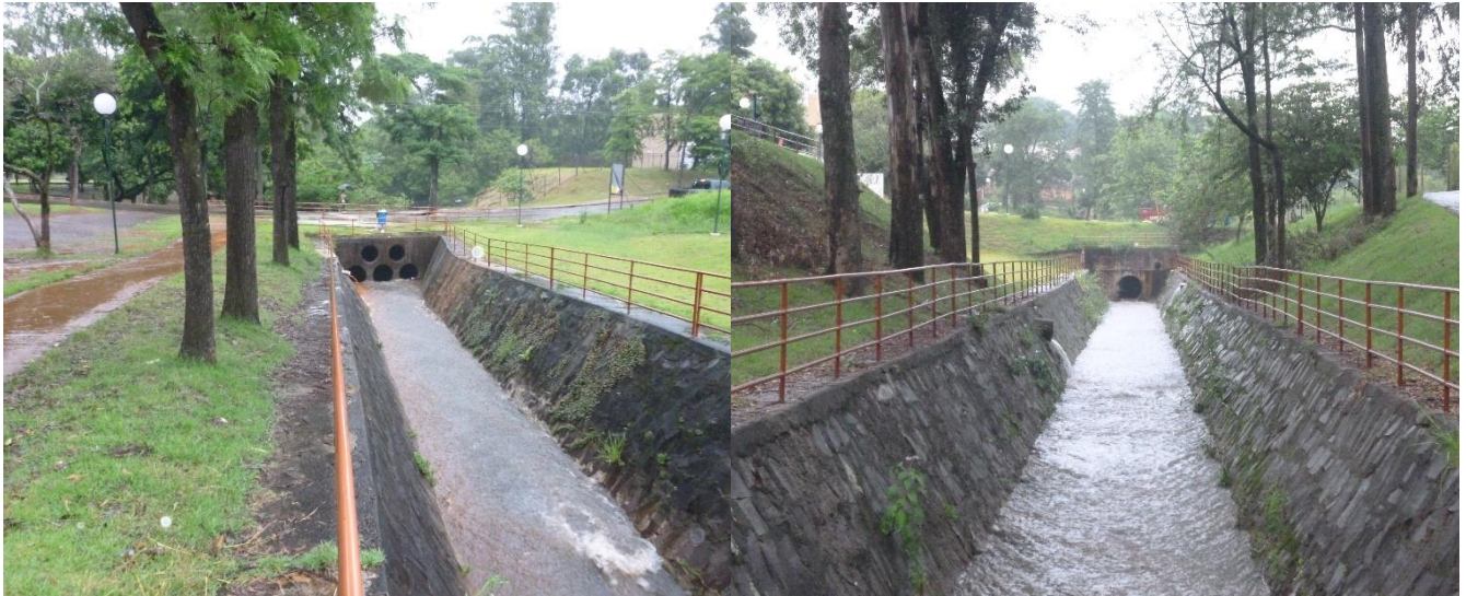
Figura 84. Canalização de manancial dentro da área urbana na cidade de Apucarana - Paraná.
