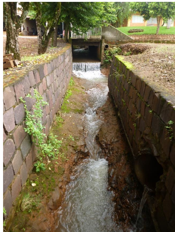
Figura 35. Pontos de lançamento de drenagem pluvial.
