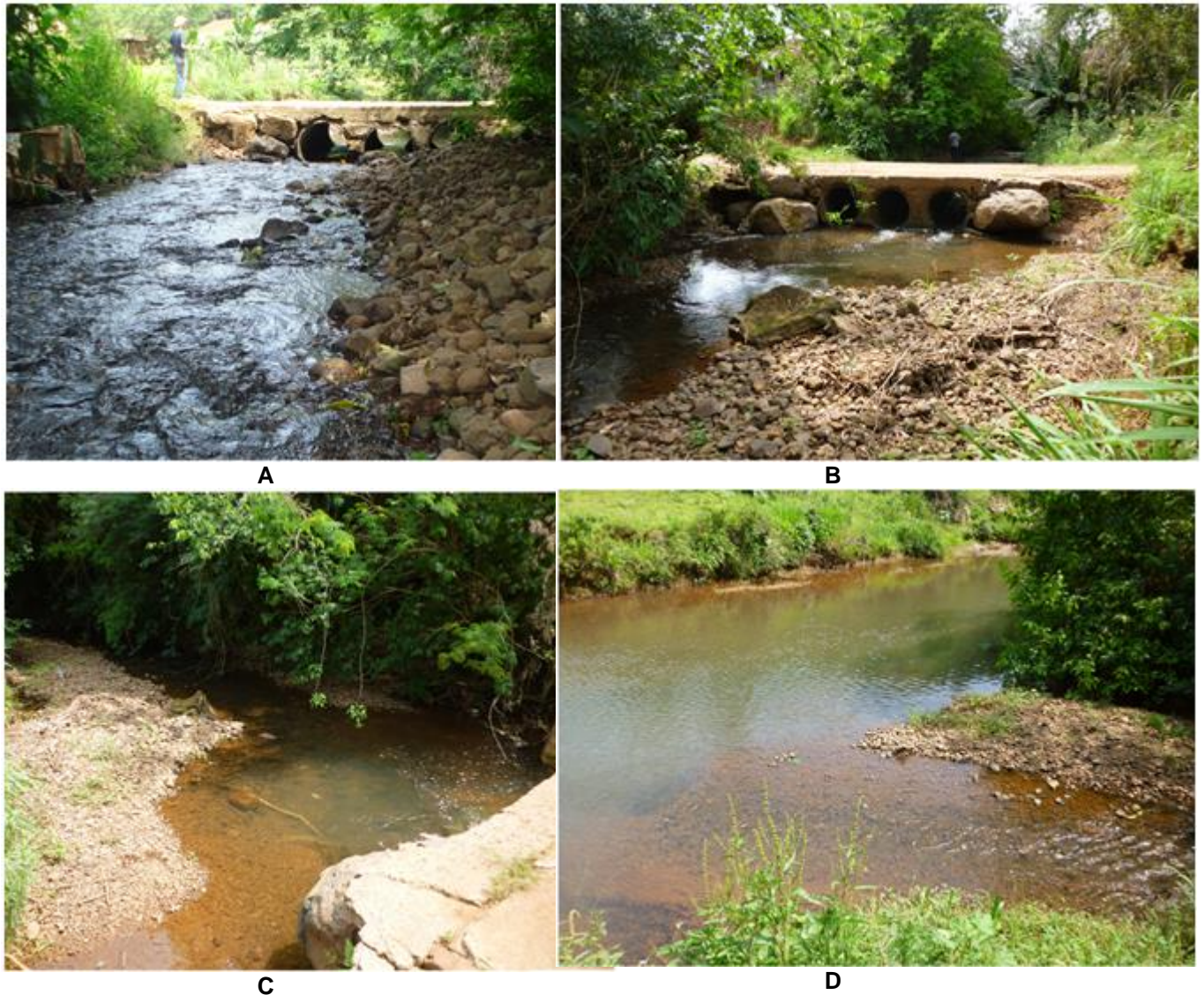
Figura 77. Imagens representando a passagem de água por uma ponte do rio Veado e seu desaguamento no rio Jundiá, no Distrito de São Pedro. Fotos A, B, C e D = ponto 48.
