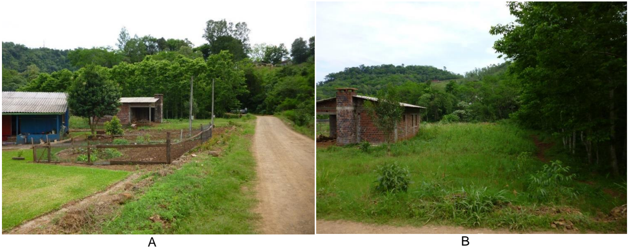
Figura 49. Exemplo de edificação em área de preservação permanente, localizada à sudeste, dentro da área de 15 metros da Figura 48. (A) Visão lateral. (B) Visão frontal.
