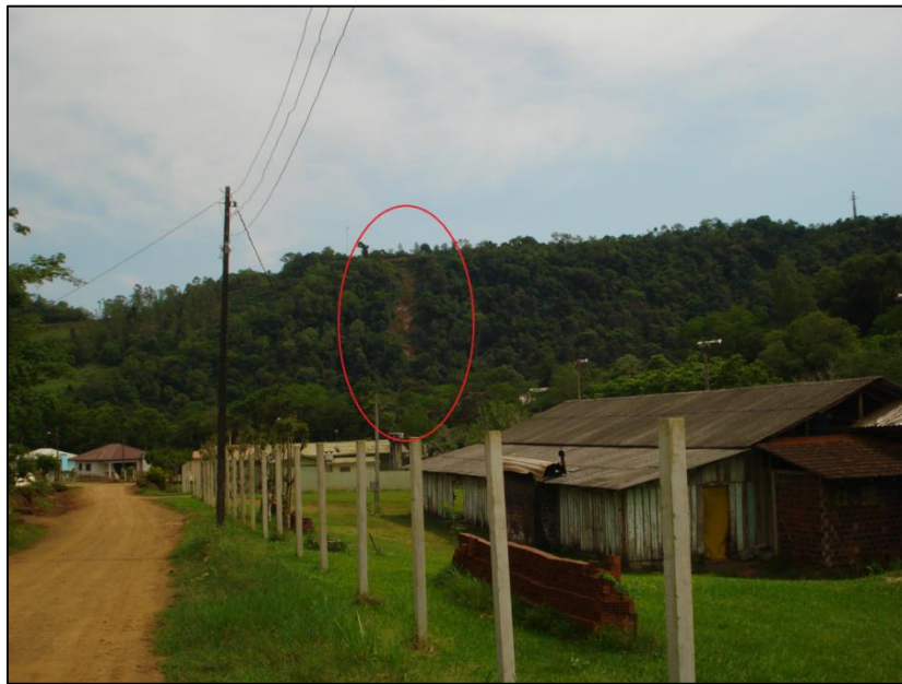
Figura 73. Escorregamento planar na encosta próxima à área urbana consolidada na Linha São Pedro.
