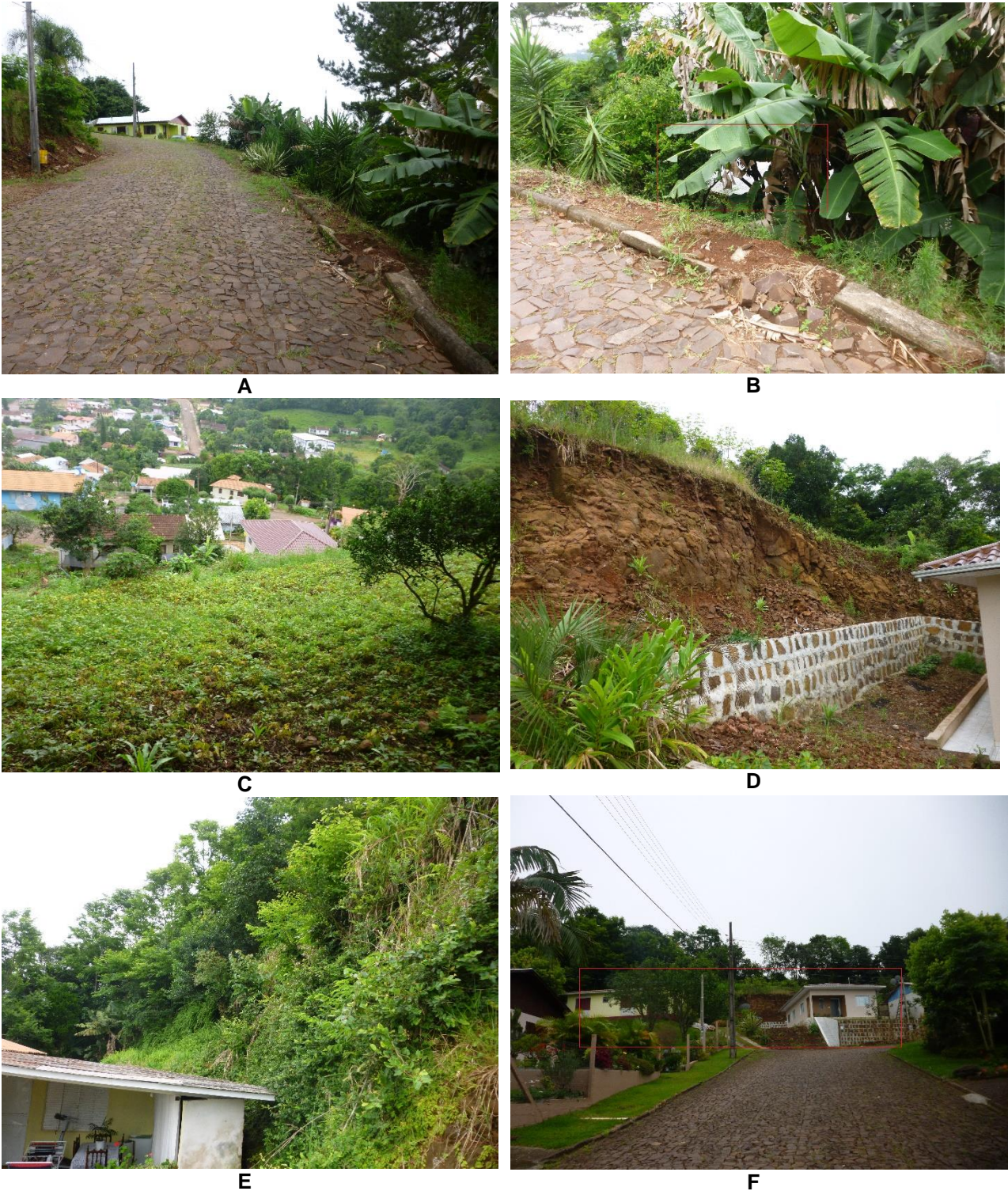
Figura 62. Registros fotográficos da área de risco localizada na Figura 61. Imagem A e B – Ponto 54. Imagem C – uso do solo na porção superior da vertente da área de risco. Imagem D e E – residências em área de risco. Imagem F – Visão frontal da área de risco.
