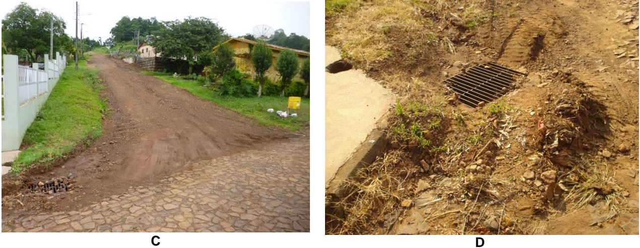
Figura 38. (A) Via sem estruturas de drenagem e pouca conservação. (B) À direita na imagem ficam as residências que recebem a água da chuva da via. (C) Rua com ausência de estruturas de drenagem. (D) acúmulo de solo e degradação da via próximo à boca de lobo, o que favorece o carreamento destes sedimentos para os cursos hídricos.
